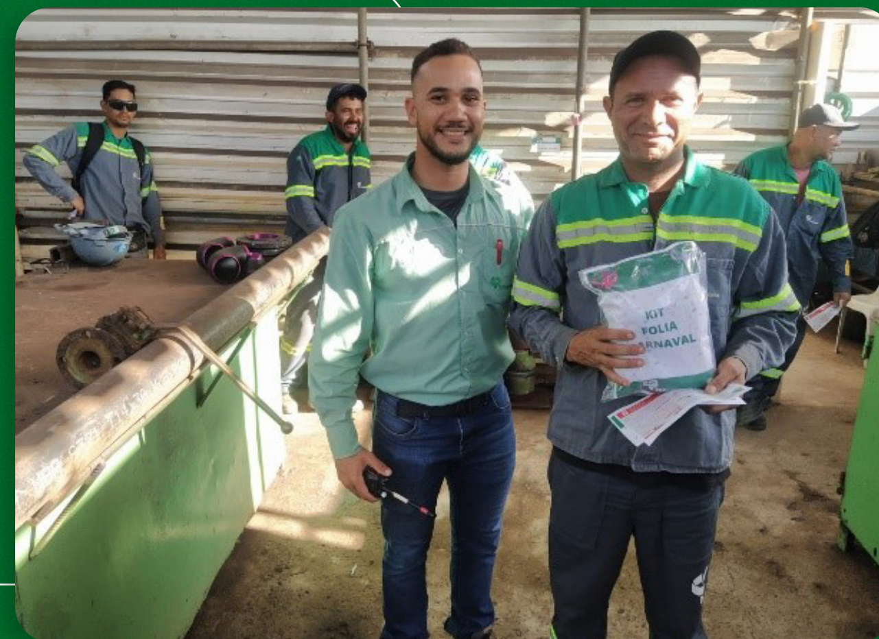
FONTE: IMAGENS NA OBRA EM MACEIÓ- AL. EQUIPE DE SEGURANÇA DO TRABALHO
