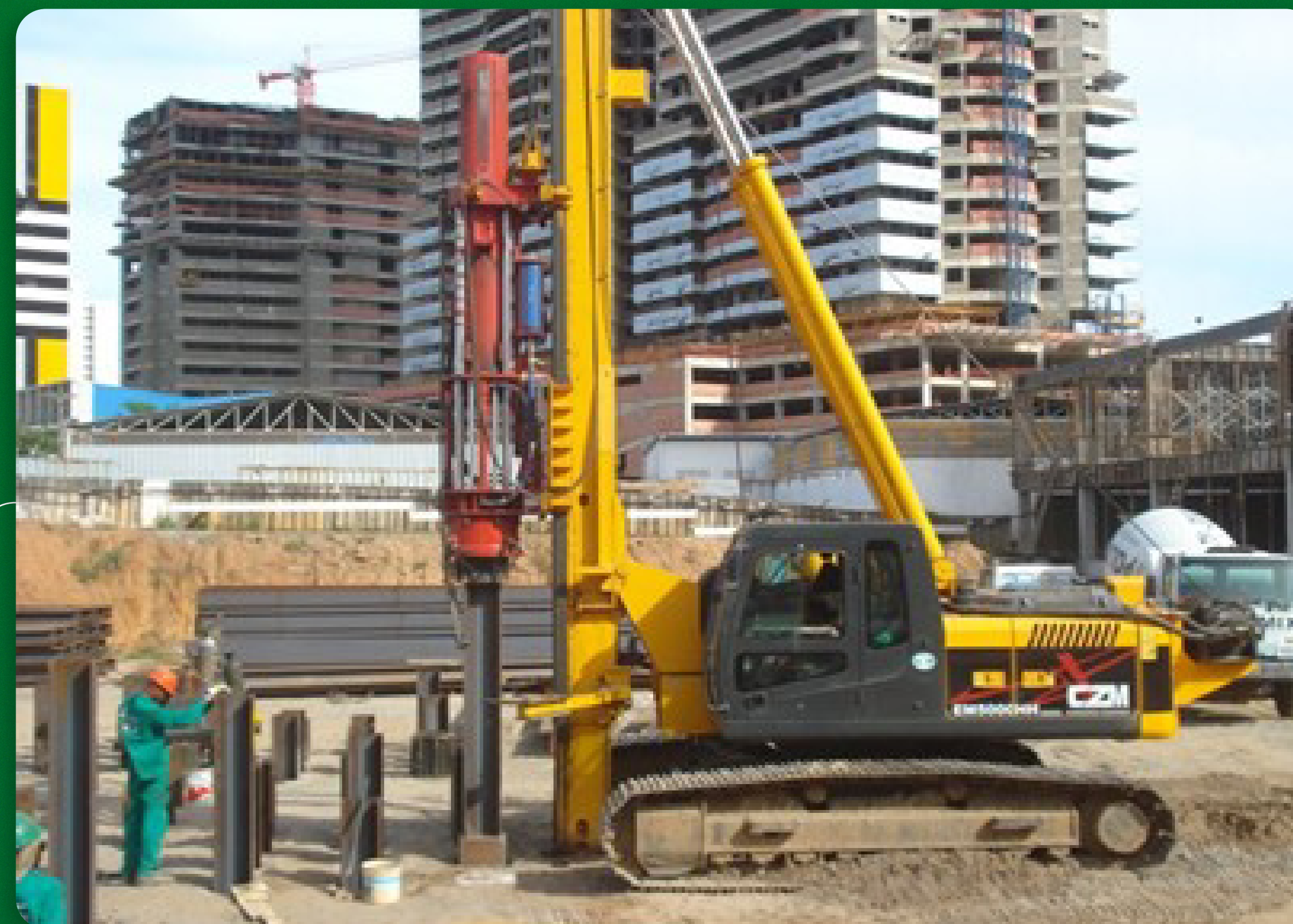
FONTE: IMAGEM DE EXECUÇÃO DE OBRA DE FUNDAÇÕES PROFUNDAS. EQUIPE DE ENGENHARIA.
