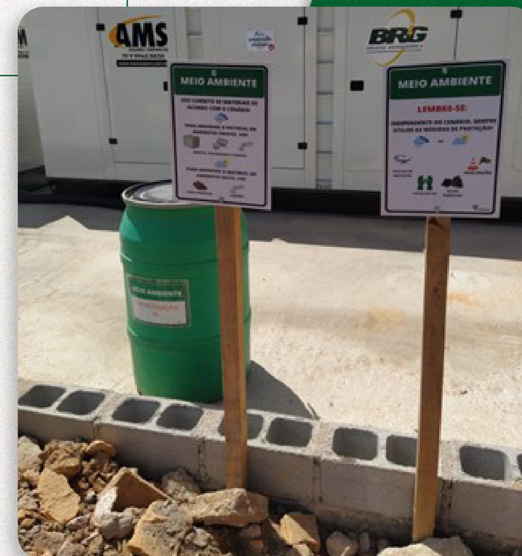
FONTE: IMAGEM NA OBRA AL 022. EQUIPE DE SEGURANÇA DO TRABALHO
