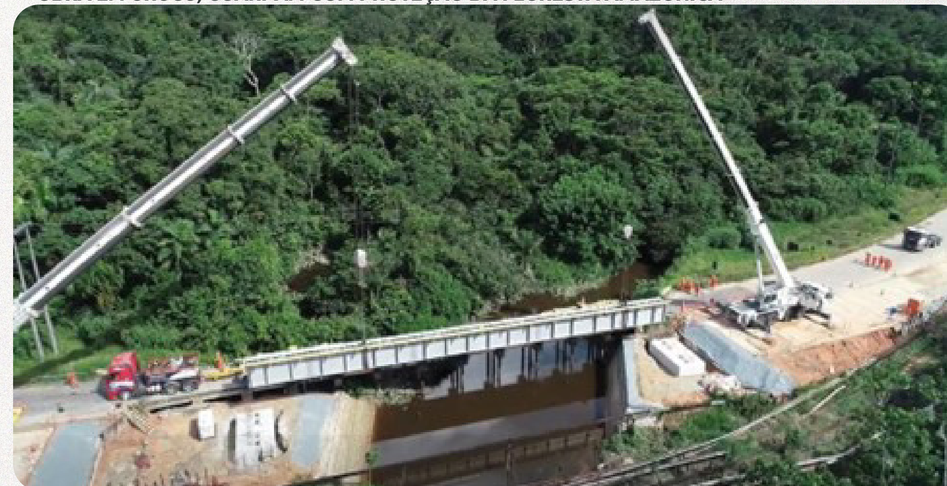
FONTE: IMAGEM DA OBRA EM URUCU-AM. EQUIPE DE ENGENHARIA.
