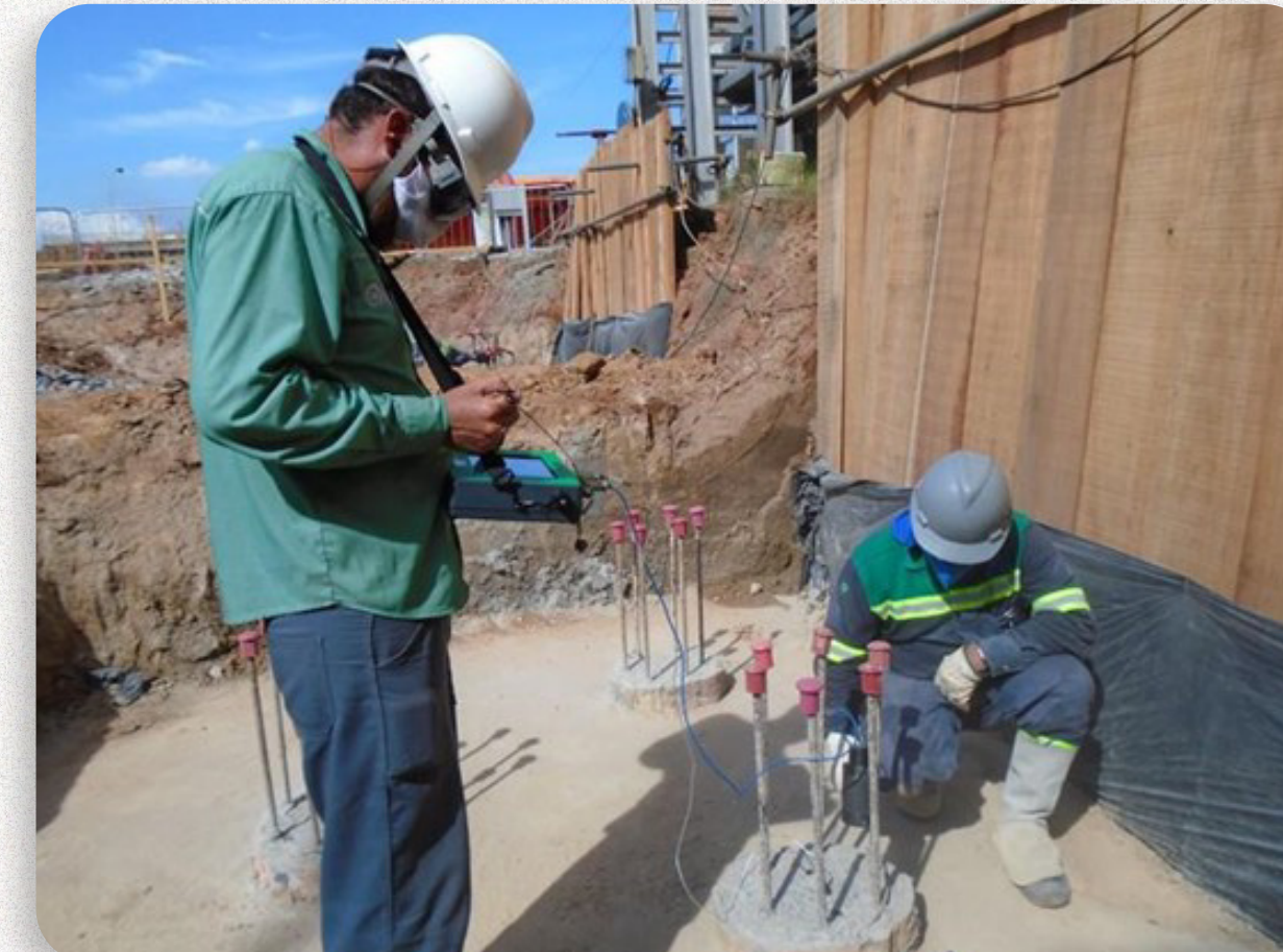
FONTE: IMAGENS DE EXECUÇÃO DE OBRA DE FUNDAÇÃO PROFUNDA. EQUIPE DE ENGENHARIA.
