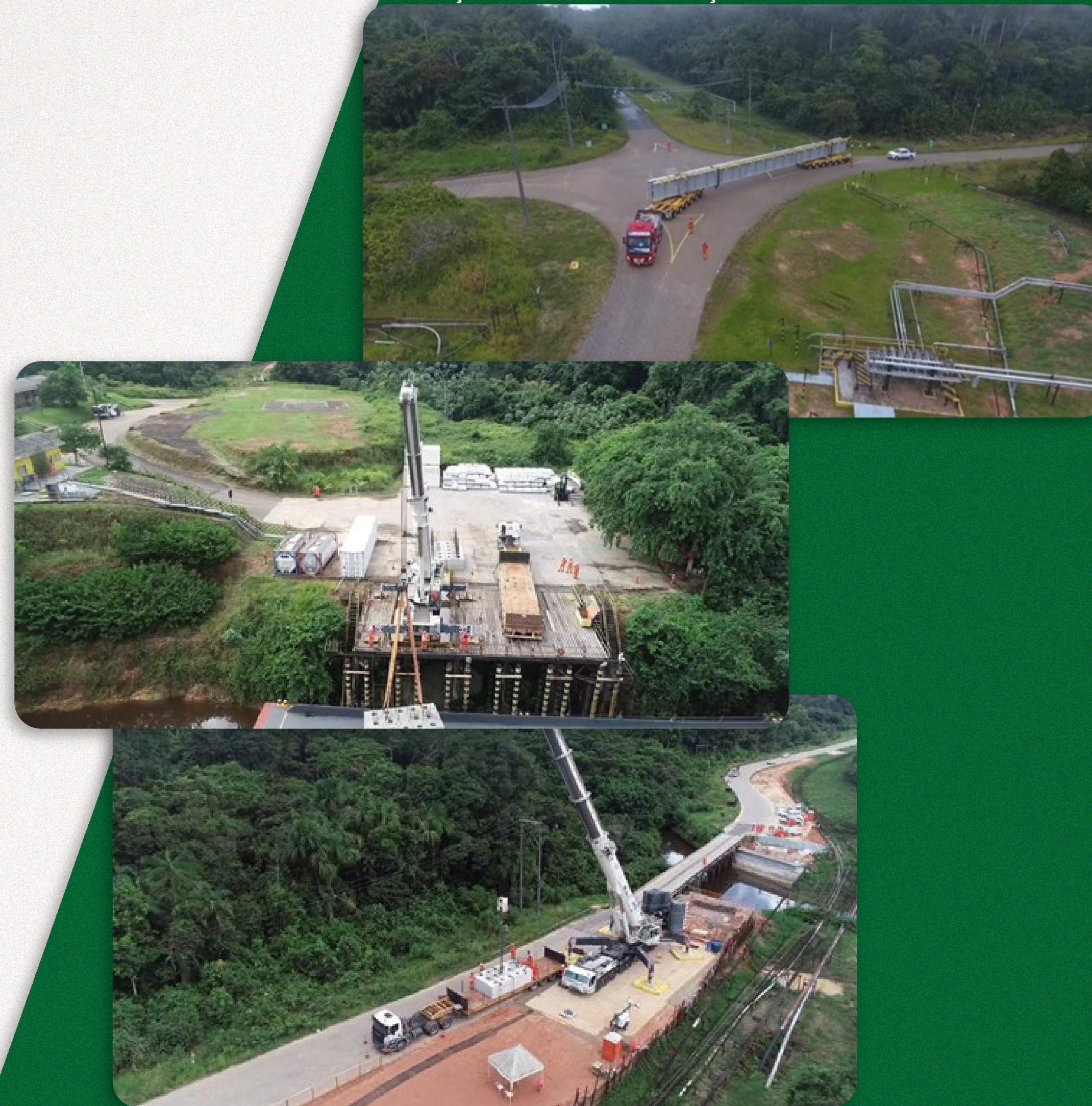
FONTE: IMAGENS DA OBRA EM URUCU-AM. EQUIPE DE ENGENHEIRA
